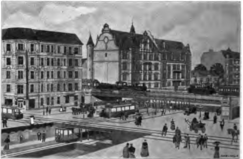
Abb. 147. Stadtbahn, Straßen- und Untergrundbahn am Zoologischen Garten.
